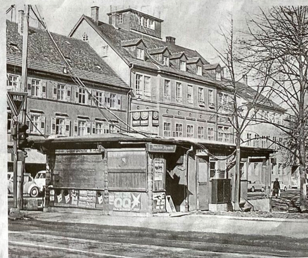
Die Halle mit Stand und Klo an der Ecke Schorndorfer-/Schlossstraße.
