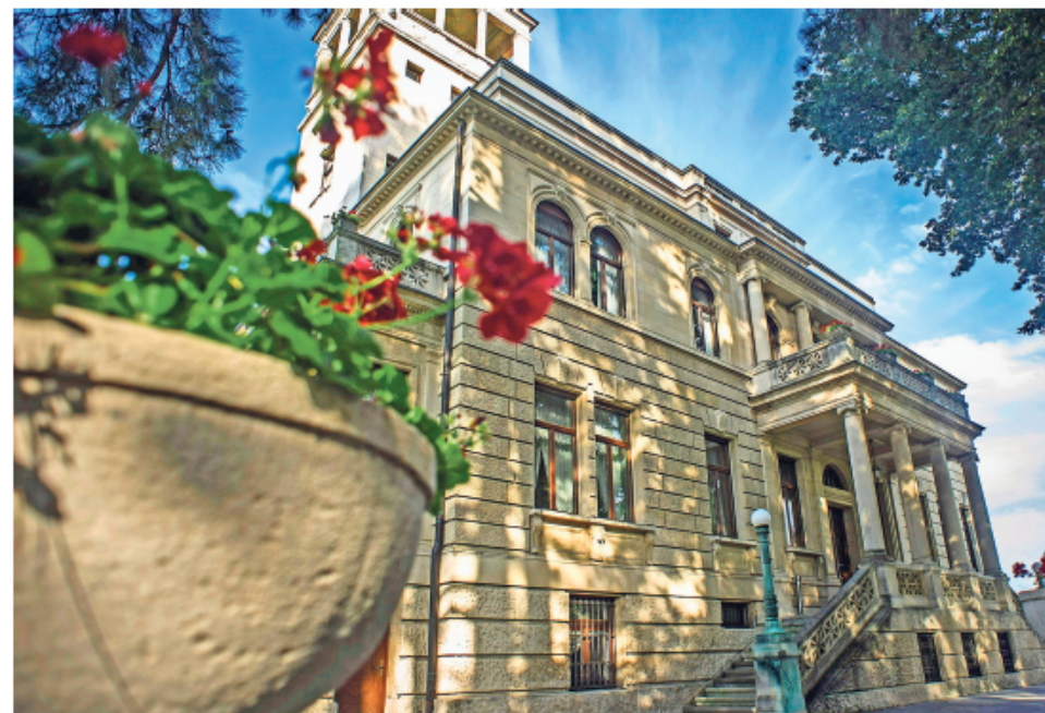
Hinter der vor über 100 Jahren gebauten Bosch-Villa auf der Gänsheide befindet sich die gespendete Stahlbank mit QR-Code und Facebook-Anschluss. Fotos: Bogen, Lg/Max Kovalenko
